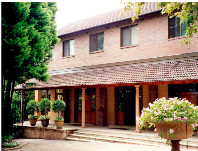
Ἡ Δυτική πλευρά τοῦ κτηρίου μετὰ τῆς αὐλῆς τῆς Θεολογικῆς μας Σχολῆς τοῦ Ἁγίου Ἀποστόλου Ἀνδρέου στό Σύννεῦ Ν.Ν.Ο.
